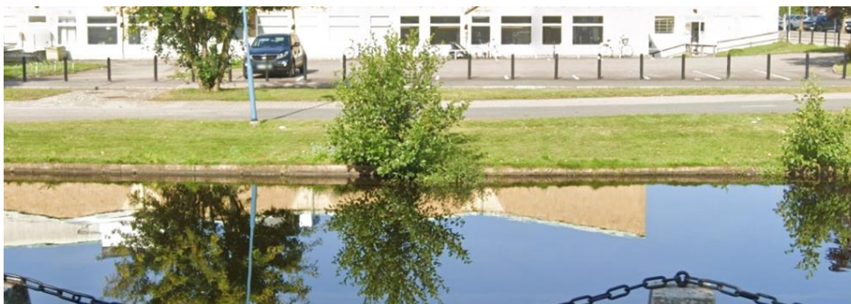
Figur 4 Delar av palissaden söder om Valhallabron, där den är uppbyggd av träpålar. Foto: Google Street view
